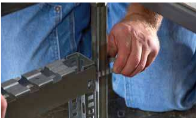
5. Dobra las pestañas del sistema FAS con un destornillador para asegurar la charola.
