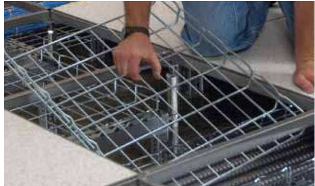
2. Utiliza el tornillo para asegurar el montaje doblando la pequeña pestaña en cada pata.
