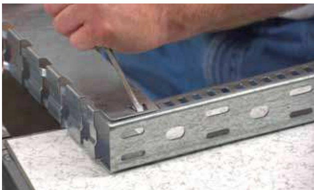
3. Coloca las dos patas montadas y asegúralas con el clip.
